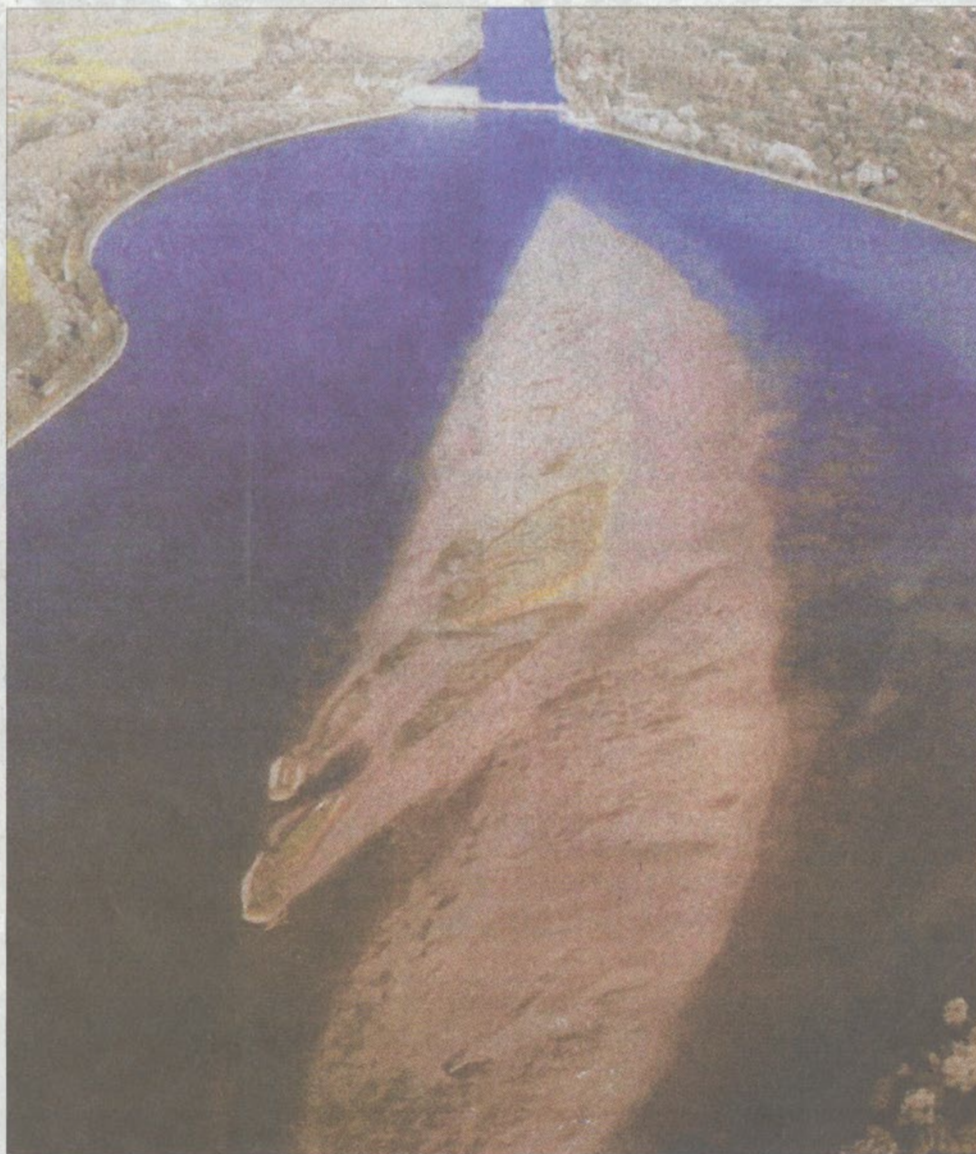
Die massive Verschlammung des Stausees Bertoldsheim beeinträchtigt die Hochwasserentwicklung an der Donau nicht – meint auch das Verwaltungsgericht München. Bild: kx
