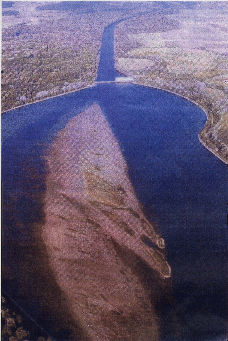
Der Stausee von Bertoldsheim. Die Luftaufnahme zeigt deutlich das Ausmaß der Verlandung. Eine Räumung – die Kraftwerksbetreiber Eon rund 20 Millionen Euro kosten würde – müsste laut Genehmigungsbescheid von 1971 jederzeit erfolgen, wenn sie behördlich angeordnet wird. Das Landratsamt hat wenigstens eine Teilentlandung angeordnet, die Regierung von Oberbayern hebt diesen Bescheid nun allerdings auf. Sie ist der Ansicht, dass die Räumung nichts bringt. Fotos: Harald Jung/Archiv
